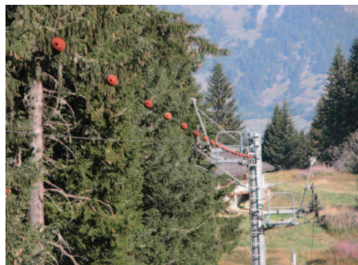
Dispositifs de visualisation des tronçons dangereux
